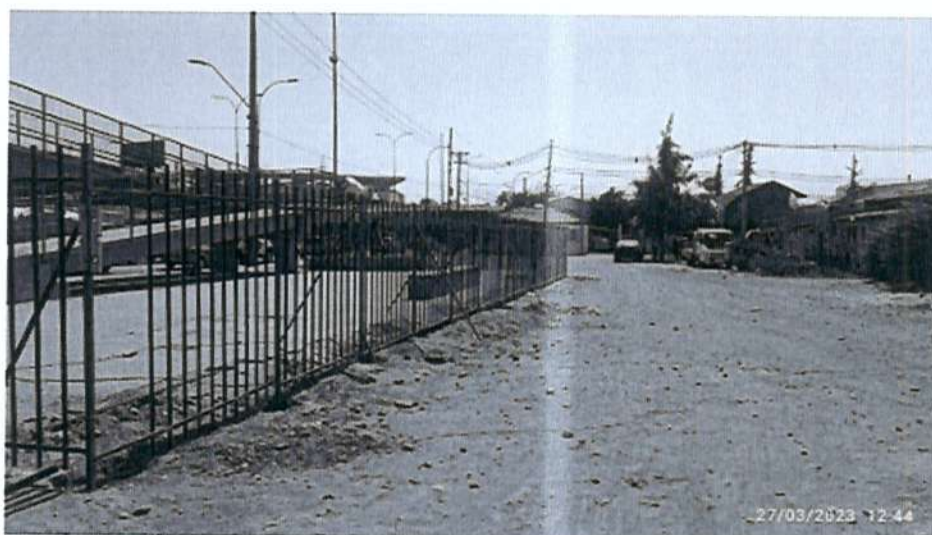
Imagen 3: Cierre perimetral del terreno para su resguardo y prevención de usos indebidos.
